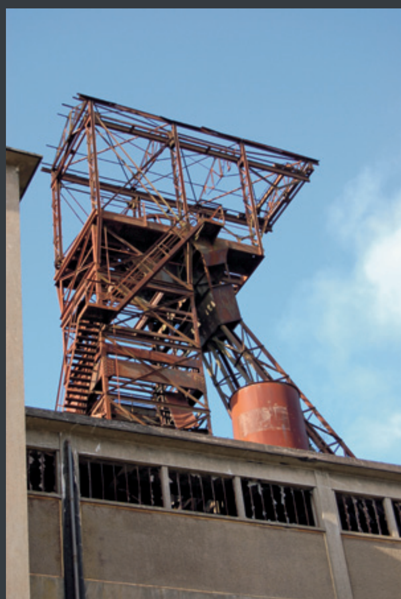
Chevalement : structure métallique pour descendre les hommes au fond du puits et remonter le minerai
