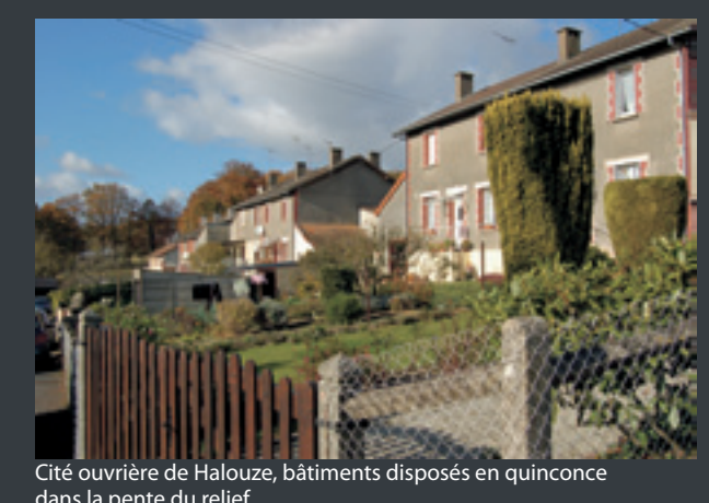
Cité ouvrière de Halouze, bâtiments disposés en quinconce dans la pente du relief
