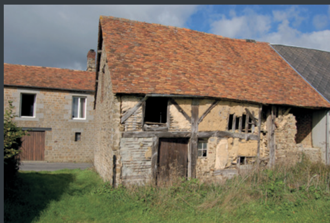
Matériaux prédominants : granite, grès, briques et toitures en tuiles plates sans lucarnes
