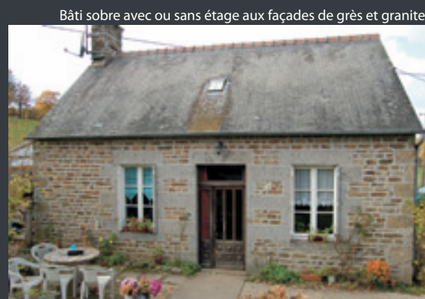
Bâti sobre avec ou sans étage aux façades de grès et granite
