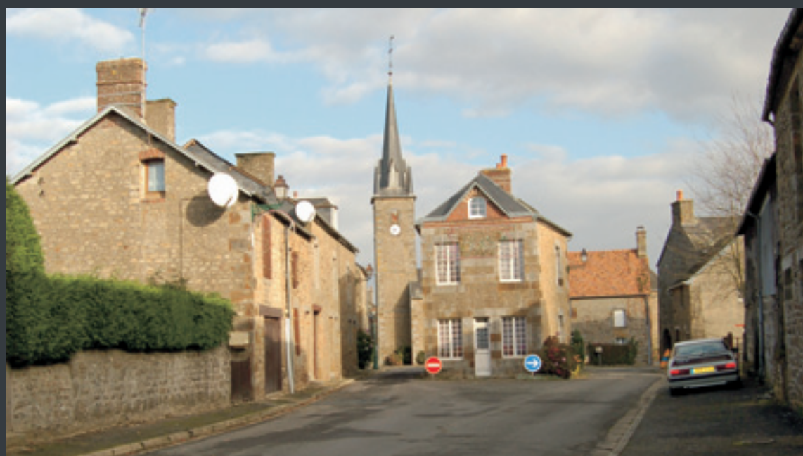
Maçonneries en moellons et pierres de taille de granite dans le bourg de Landigou
