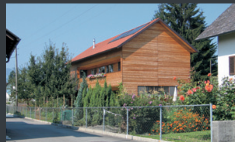
L'habitat économe en énergie se caractérise par des volumes très compacts et un nombre limité de façades exposées aux intempéries
